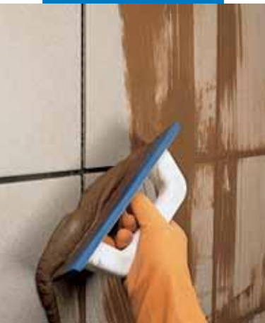
Затирка швов шпателем снаружи помещений
