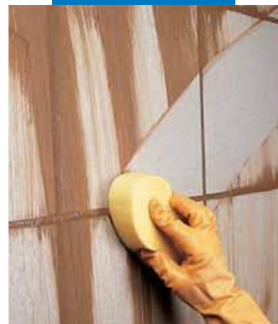
Очистка плитки при помощи губки
