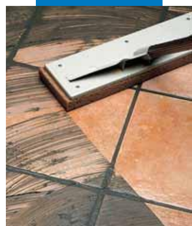
Очистка пола, облицованного плиткой одинарного обжига, при помощи ракля с губкой
